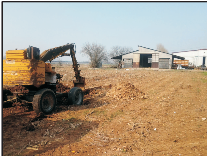
Foto n. 1 - collocazione trincea esplorativa
