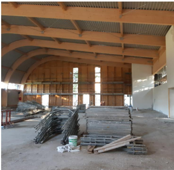
a struttura di legno, composta da doppia lastra in cartongesso, barriera al vapore, travi di struttura, isolamento in lana di roccia, pannello OSB, listelli verticali e rivestimento esterno in lamiera aggraffata in alluminio.
