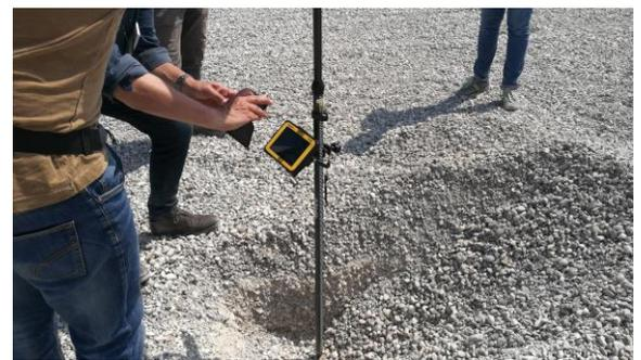
Foto 7: Verifica spessore materiale drenante - giugno
