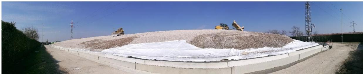
Foto 10: lavori conclusivi di posa dello strato di ghiaia di drenaggio delle acque meteoriche lungo il lato sud - luglio
