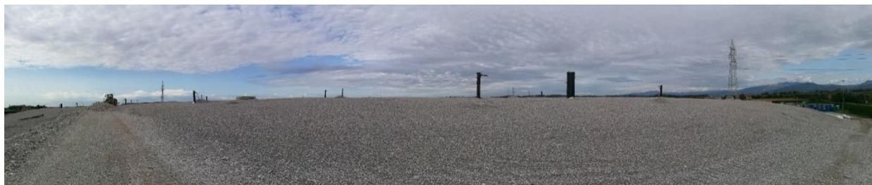
Foto 11: Lotti 4 e 5 dopo la posa dello strato di ghiaia di drenaggio delle acque meteoriche. Vista verso sud-ovest - agosto
