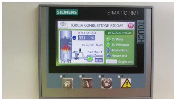
Foto 17: PLC torcia di combustione T1
