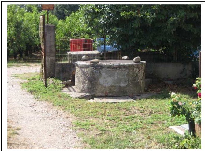
A sinistra la foto di un pozzo privato che intercetta la falda superficiale di un acquifero inframorenico in località Balconi Rossi alla profondità di circa 8 metri. A sinistra pozzo per l'irrigazione in località Gorgo che raggiunge una profondità di 70 metri
