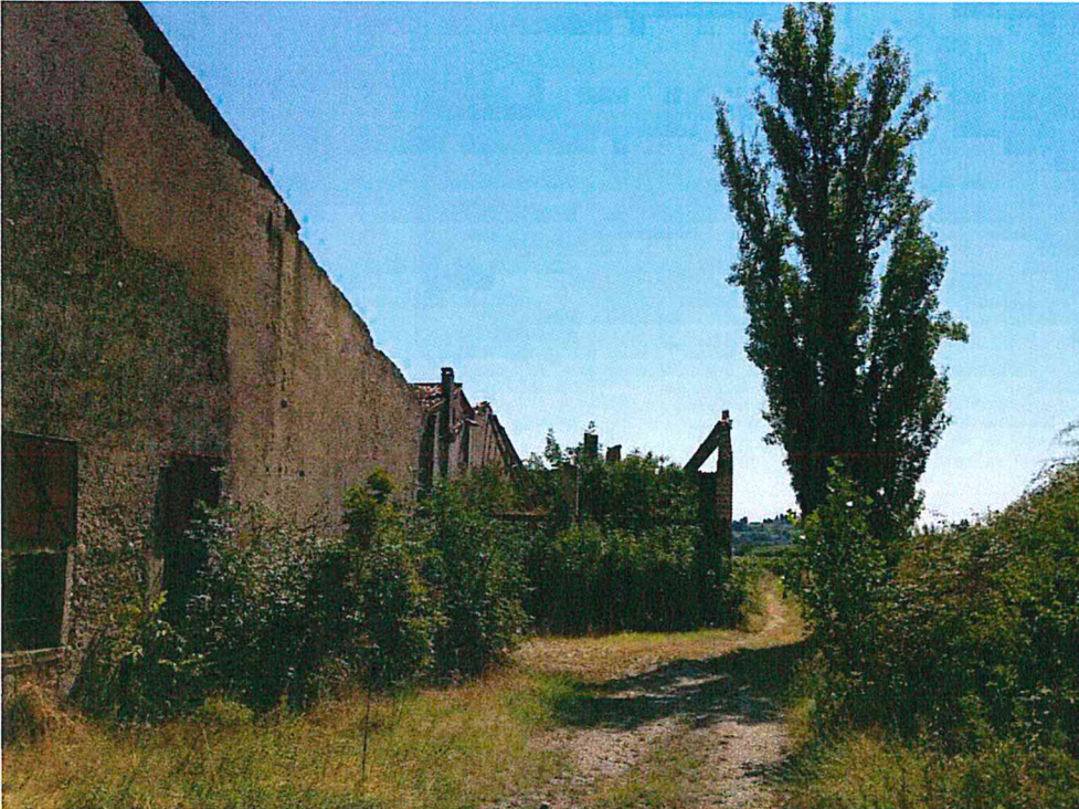
Figura 10. FOTO 2.a: Strada sterrata interna alla proprietà vista dall'ingresso alla stessa.
