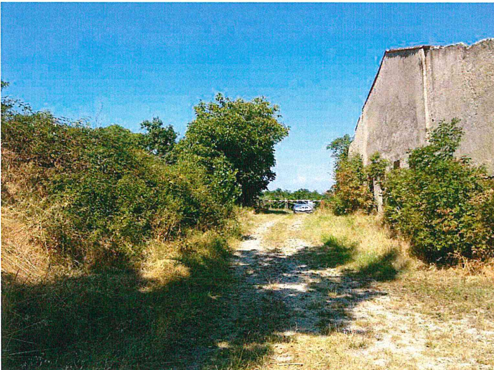
Figura 11. FOTO 2.b: Vista dell'ingresso alla proprietà e della strada sterrata interna alla proprietà.
