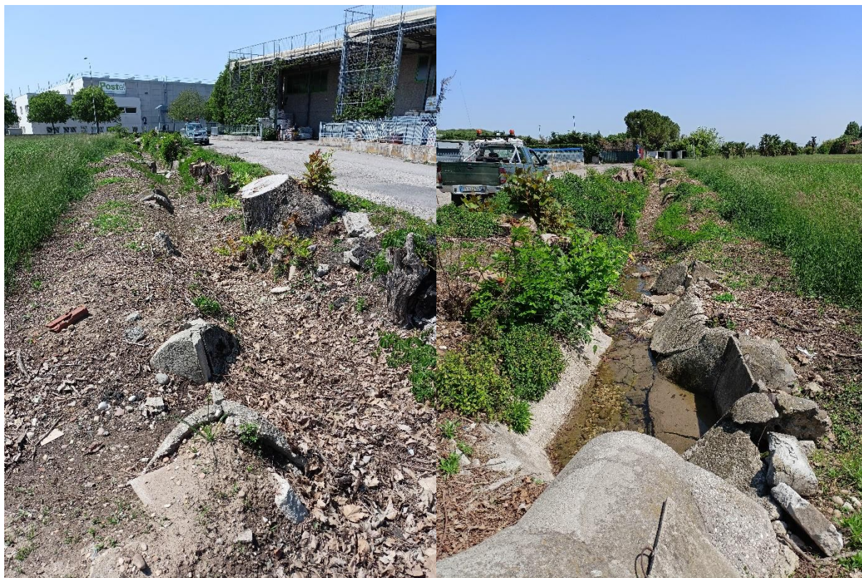
Figura 4-7: Vista da est (sx) e da ovest (dx) del canale 39/260 abbandonato.
