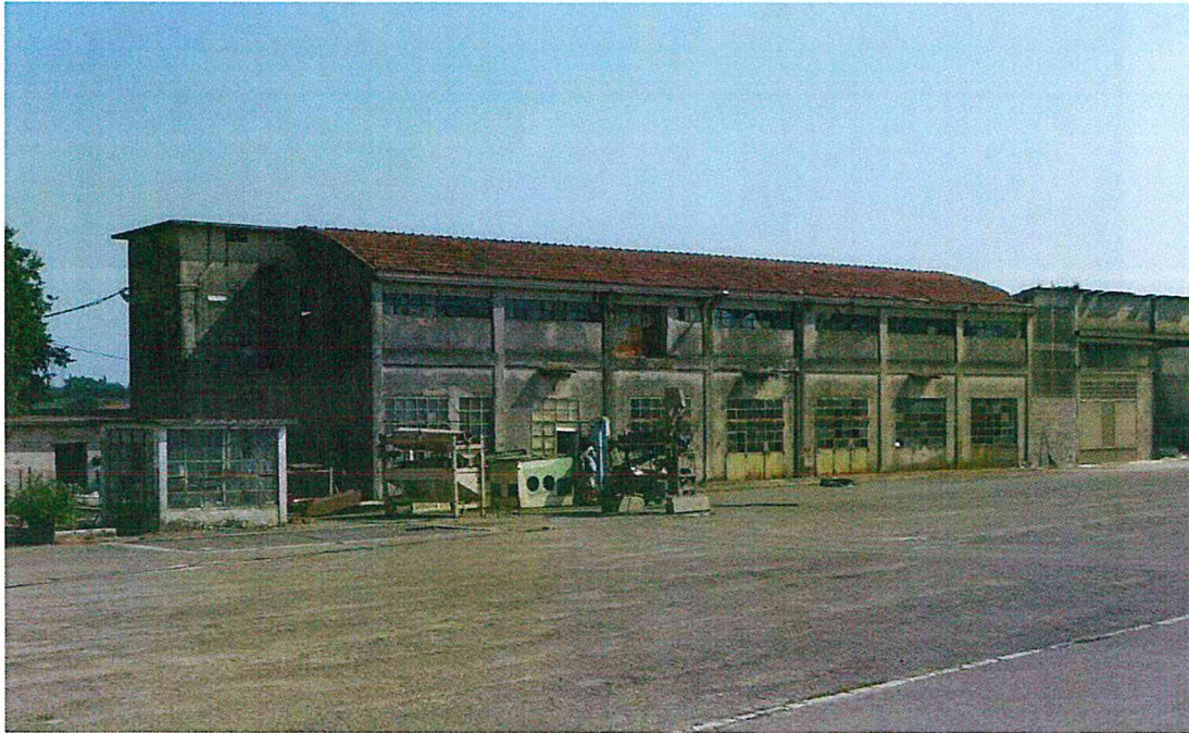
Figura 23_Vista dall'interno dell'area del fabbricato H). In secondo piano sulla destra si intravede il fabbricato I)
