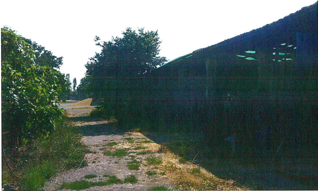
Figura 25_Vista del fronte interno del fabbricato L).
