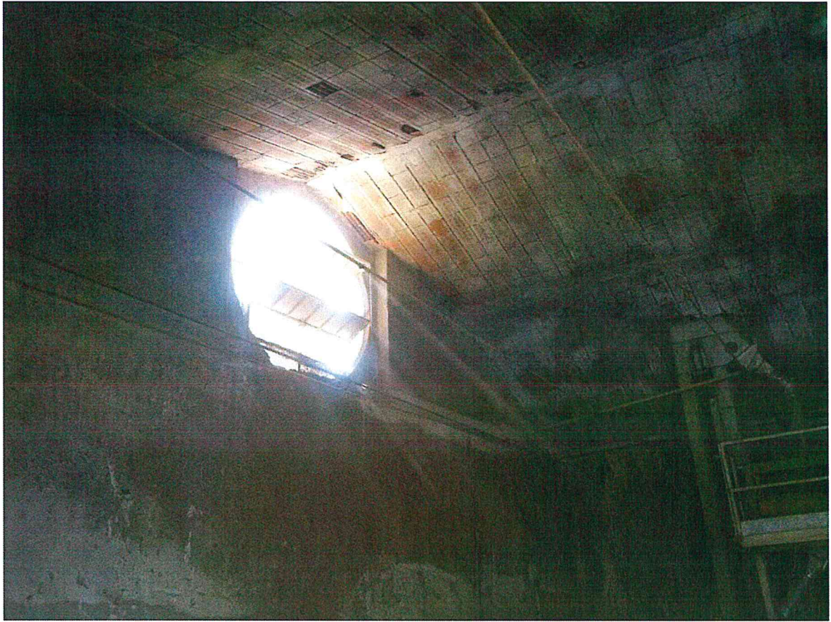
Figura 8_ Vista dell'interno di uno dei fabbricati esistenti. Dettaglio della parete verso Custoza con in evidenza la finestra di forma circolare in controluce.
