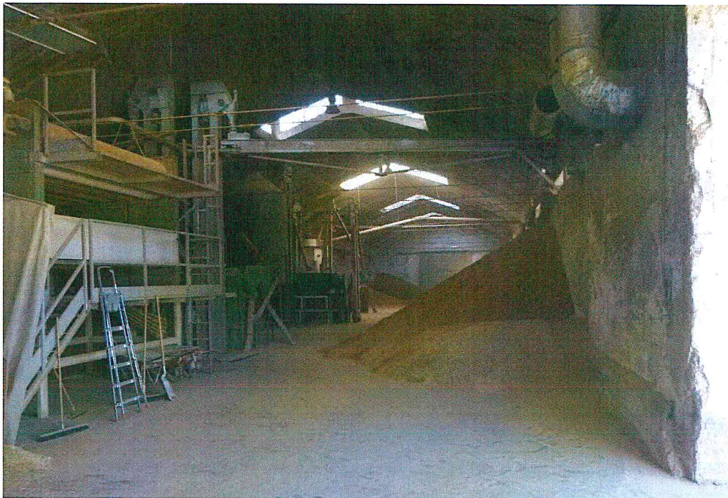
Figura 17_Vista dell'interno del fabbricato B)
