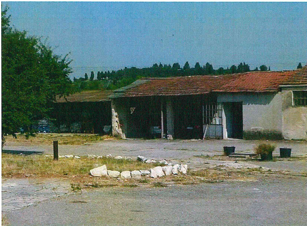
Figura 28_Vista interna del fabbricato N).
