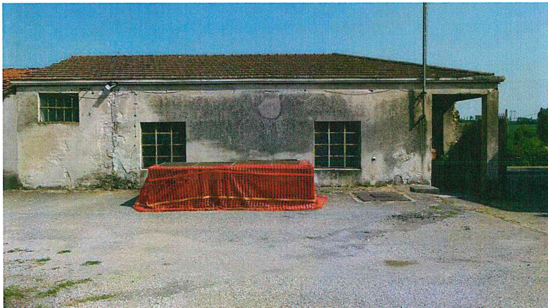
Figura 26_Vista del lato interno del fabbricato M).
