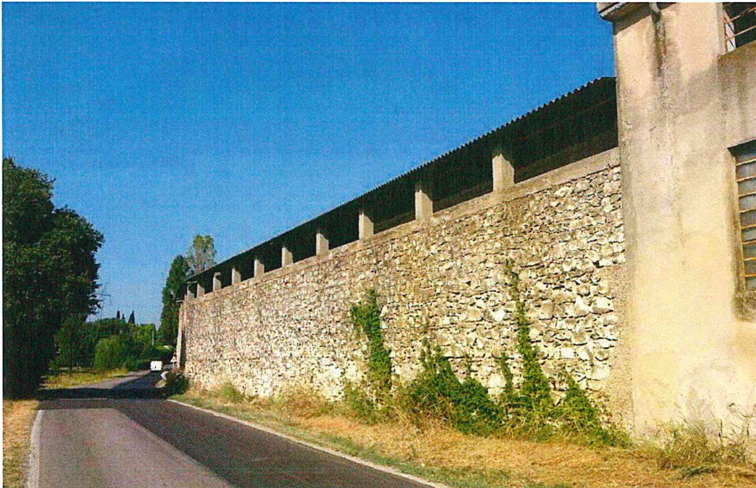
Figura 24_Vista del fronte verso Strada Sommacampagna dell'edificio I). Risulta evidente come la realizzazione del fabbricato sia avvenuta sfruttando l'esistenza del muro in sasso esistente.
