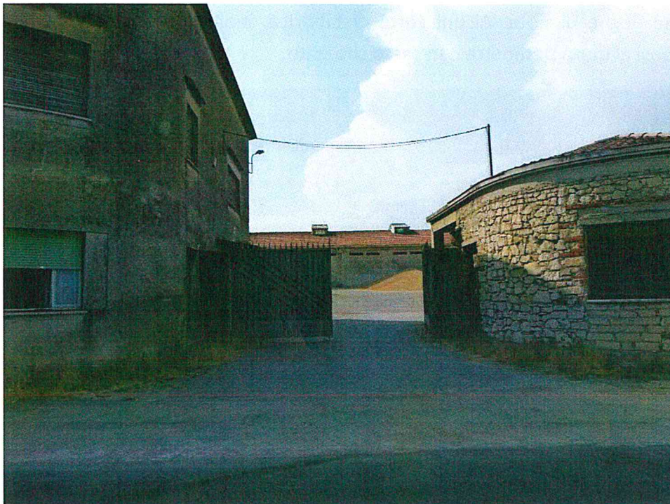
Figura 21_L'accesso all'ex-Conceria dalla strada.
