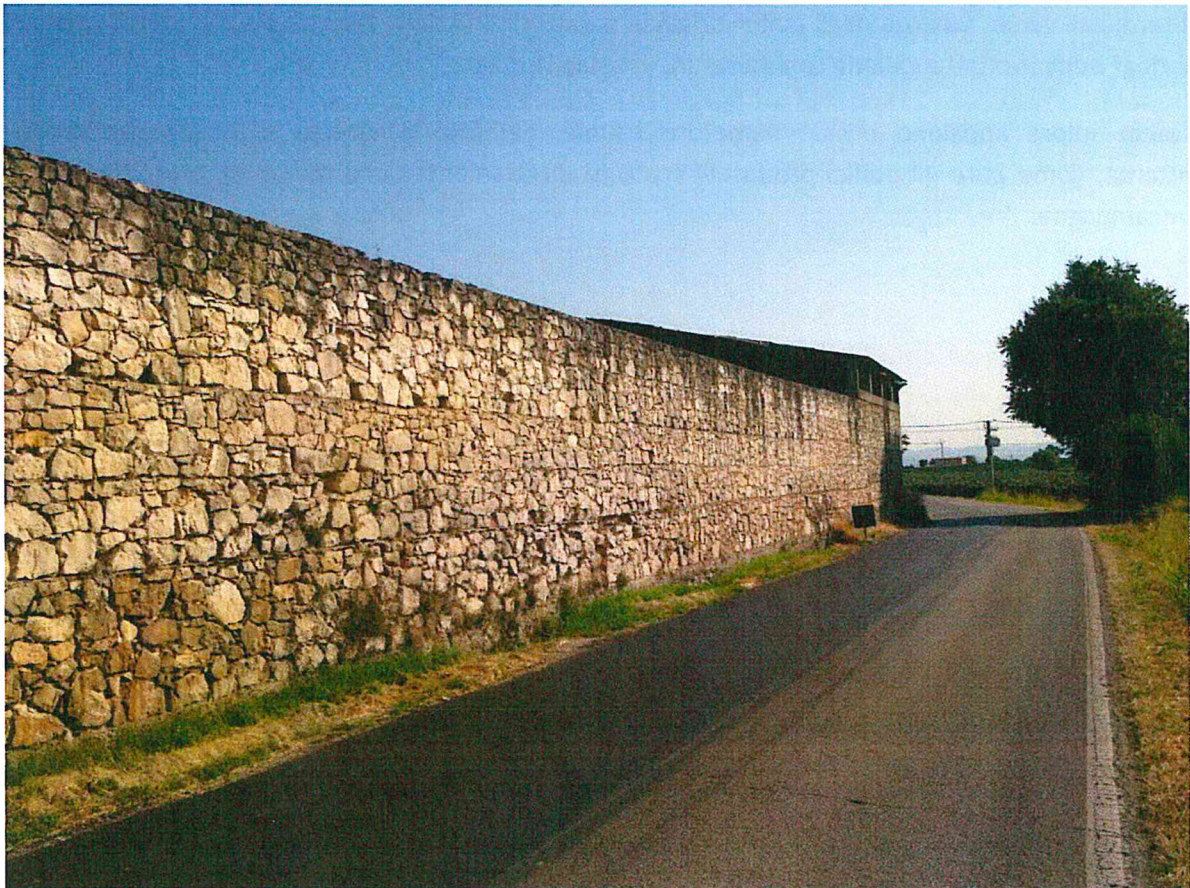
Figura 9_ Vista del recinto in sasso sbizzato dalla strada che conduce verso Sommacampagna. In evidenza nella parte più estrema verso destra del muro uno dei fabbricati costruiti in adiacenza e sopra al muro in sasso sbizzato.
