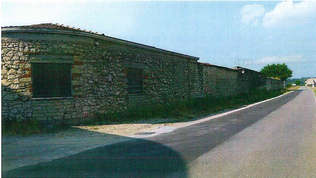
Figura 27_Vista del fronte strada del fabbricato M). Come si può notare per la realizzazione di tale edificio è stato sfruttato completamente l'esistenza del muro in sasso sbazzato.
