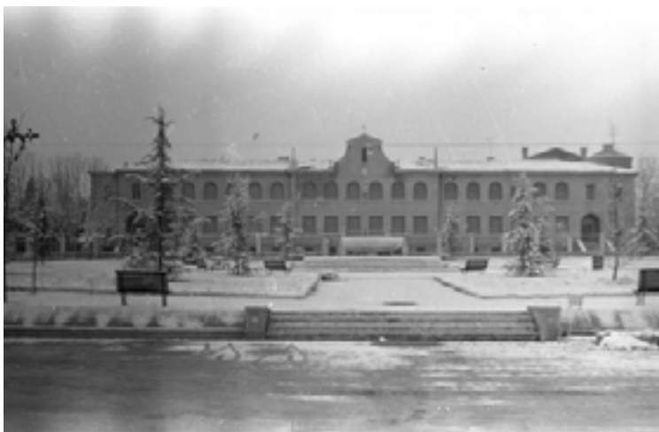
Vecchie scuole a lavori ultimati con definizione impianto attuale della piazza
