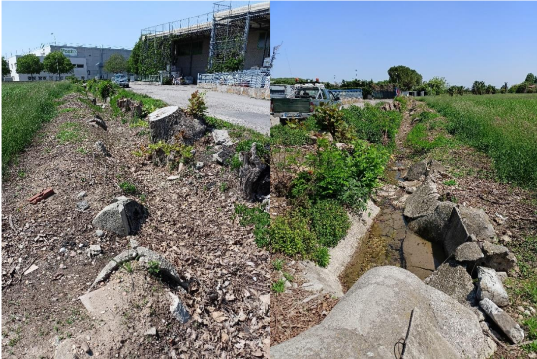
Figura 4-7: Vista da est (sx) e da ovest (dx) del canale superficiale 39/260 abbandonato.
