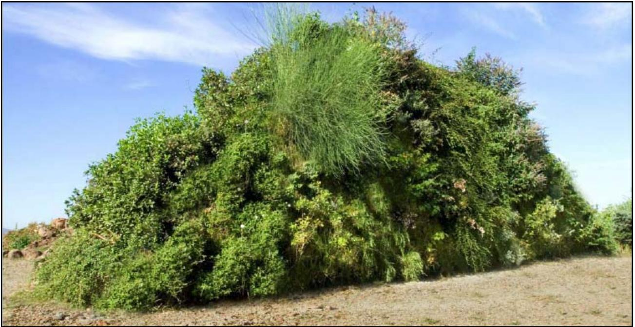
Figura 6.3 Esempio sistema Baerma - muro vegetato (fonte: <http://www.maccaferri.com>)
