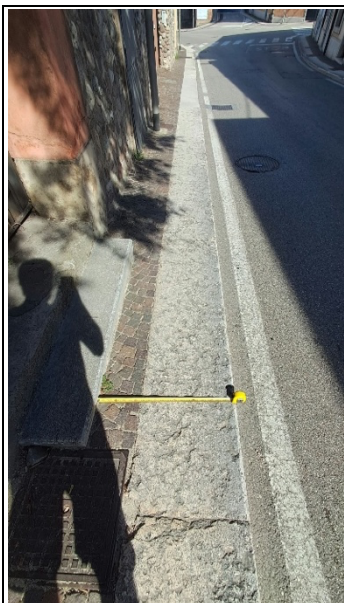
Foto 1: In corrispondenza di via Pigno 9 – scalino riduce la larghezza utile da 90 cm a 70cm
