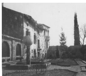
1932-33 Costruzione della torretta e demolizione del corpo di fabbrica basso. Rimane in piedi un muro.
