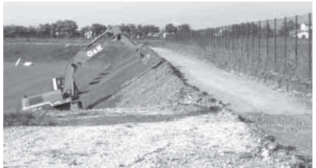
Anello ciclabile in costruzione a Caselle.
