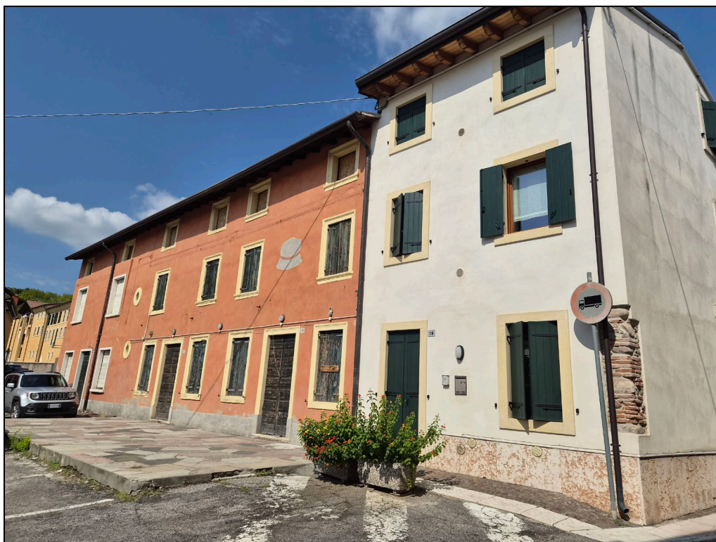
Foto 3 - Prospetto Principale su P.zza Marconi – Vista da Via Pontirolli
