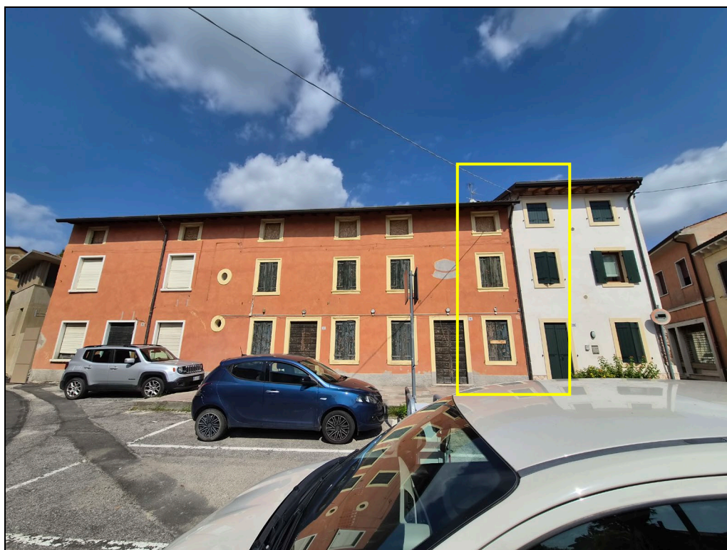
Evidenza della differenza di altezza in gronda
