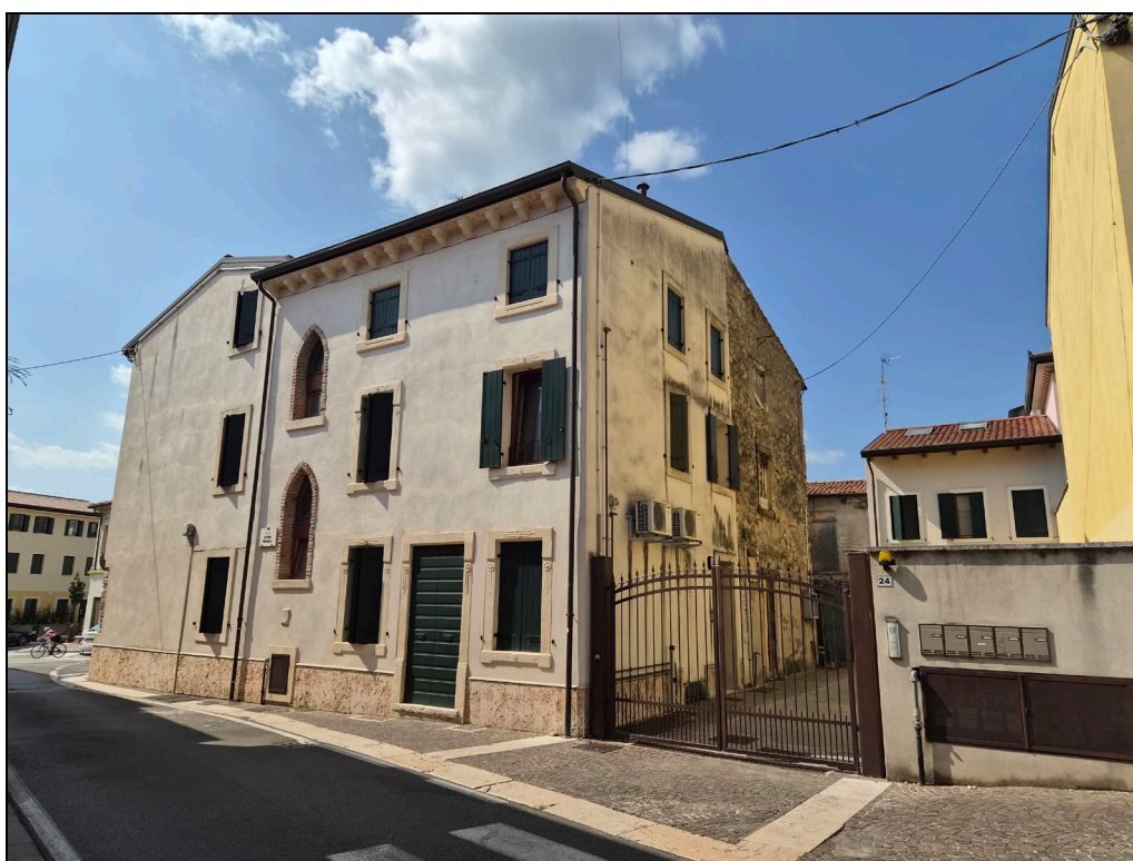
Foto 4 - Ingresso cortile interno – Vista da Via Pontirolli
