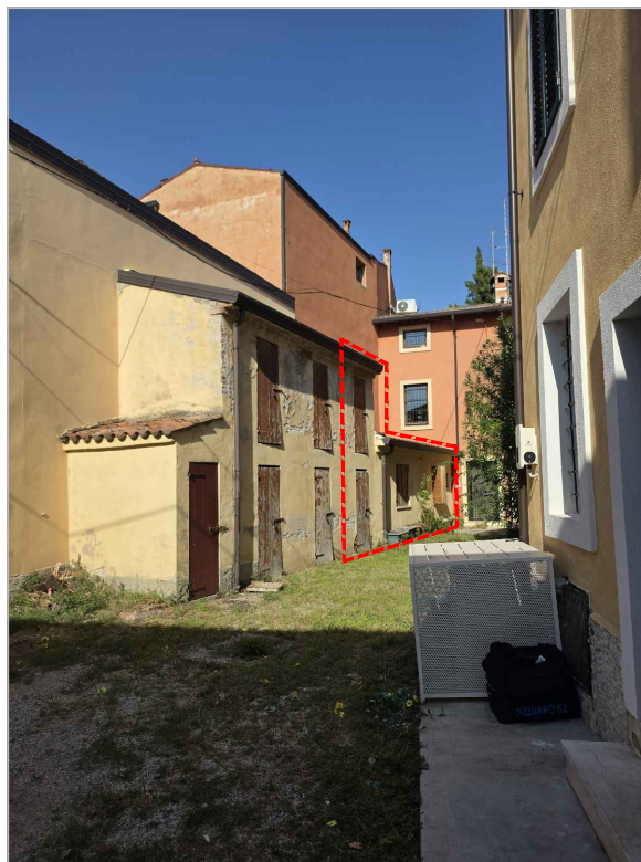
Foto 4 - Corte interna e corpo di fabbrica minore
